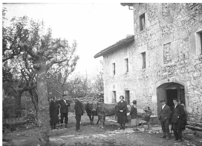
Fachada del caserío en 1932, en la que hay continuidad de la fábrica de los dos cuerpos.
