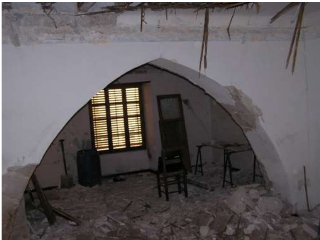
Dalt, la tercera crugia de la planta superior. Baix, la que dona a la façana, amb la finestra. Fotos V.TORREGROSA, 1995
