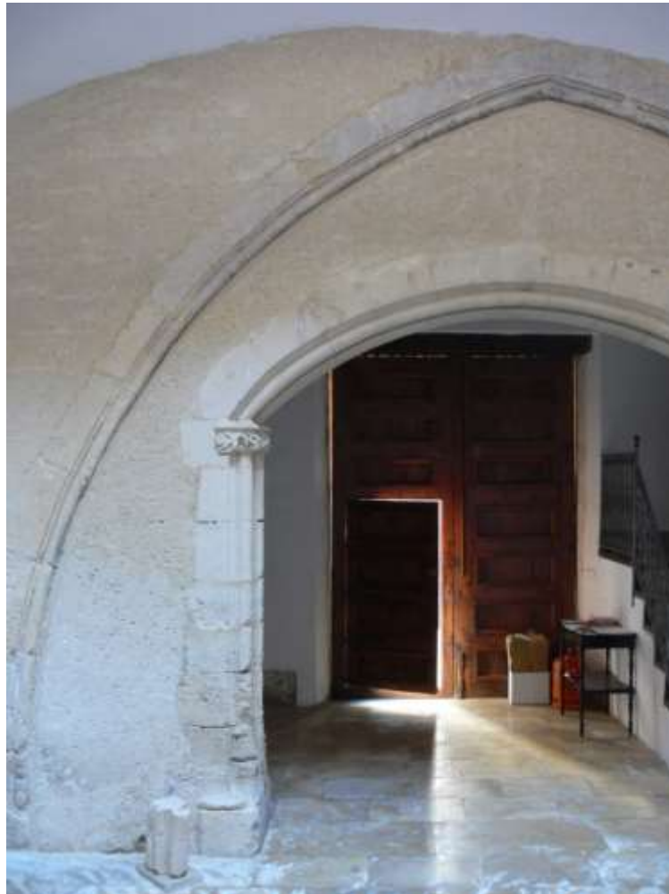
Arc de primers del XVI, inscrit en el més ample del XIV, i potser fet alhora de l'eliminació de l'escala, per mantindre el pes de l'arc volat d'accés a la planta primera. Foto MGB 2018.
