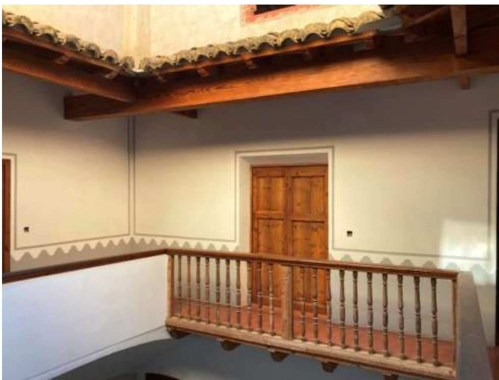
Perfilat de portes i paraments, i faldó o socolada del corredor perimetral de la planta primera. Foto MGB. 2025
