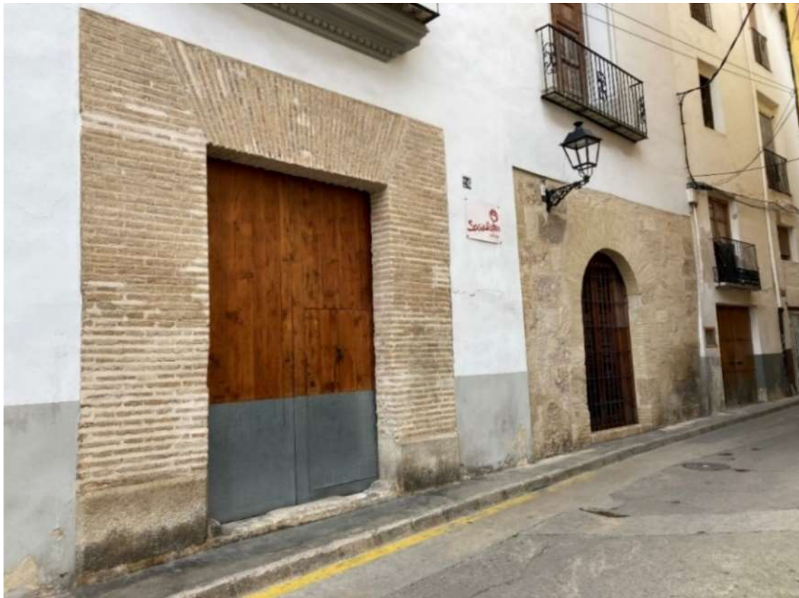
A l'esquerra, porta principal de la casa, construïda amb maons de pla remarcats per subtils ratlles negres. Foto MGB, 2025.
