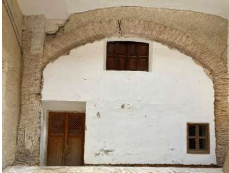
Arc escarser construït per rebre la descàrrega del mur alçat per ampliar la casa. Foto MGB. 2018
