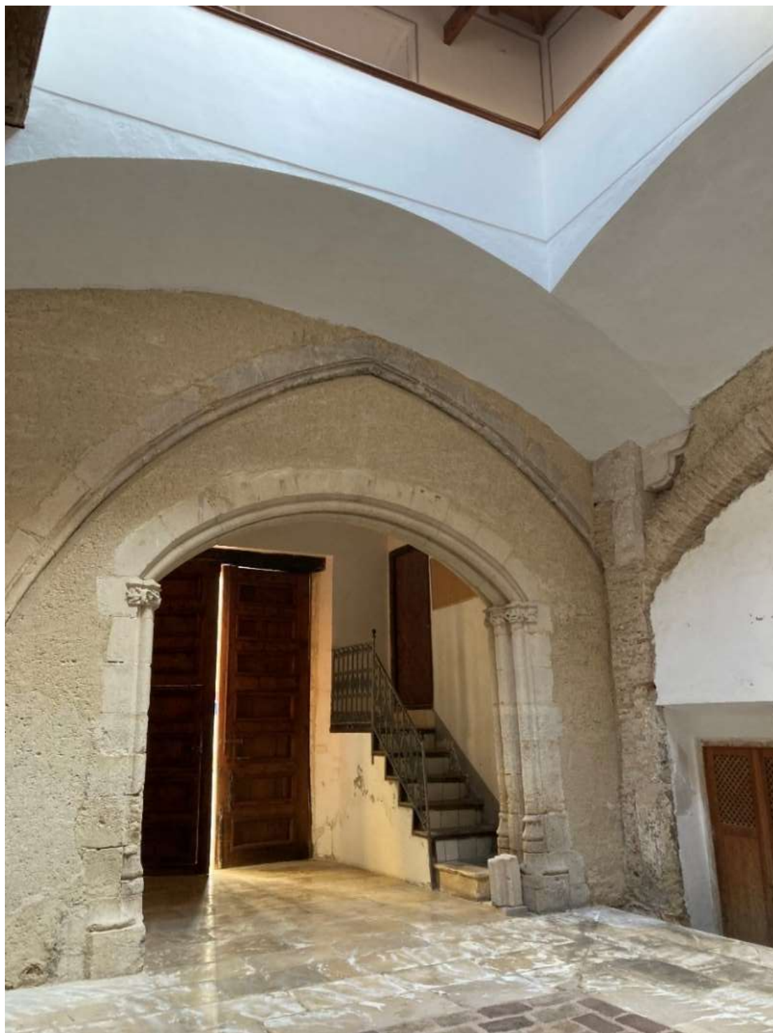
Entrada i pati de la casa, amb l'arc ogival peraltat i la sabata d'arribada de l'escala volada la part dreta superior, formant el nient de la volta tabicada d'aresta del corredor. Foto MGB. 2019.
