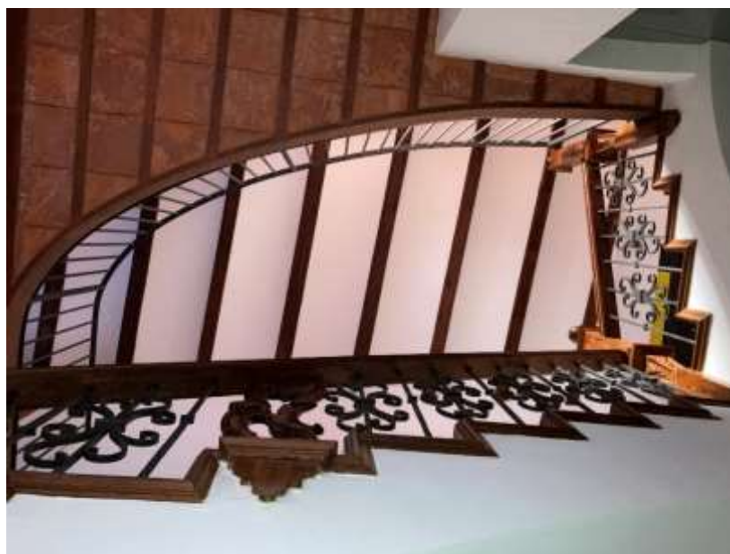
Solució de l'arribada de l'escala a la primera planta per comunicar totes les dependències, segons projecte de Vicent Torregrosa. Fotos MGB. 2025.
