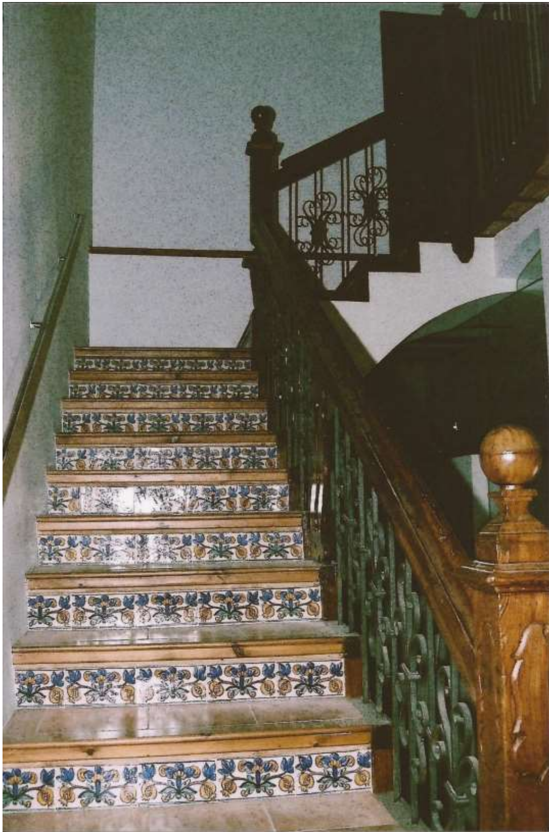
Escala amb les contrapetges. Foto JMC. 2013
