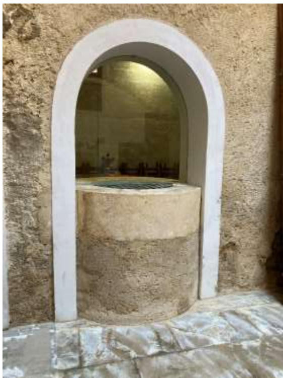
Brocal del pou obert en el mur existent entre el pati, a l'esquerra i la sala gòtica, a dreta. Fotos MGB. 2025
