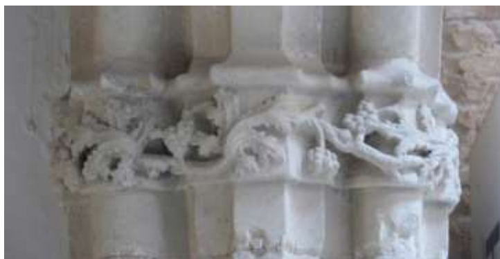
Detall del capitell dels pilars fasciculats. Foto MGB. 2018.
