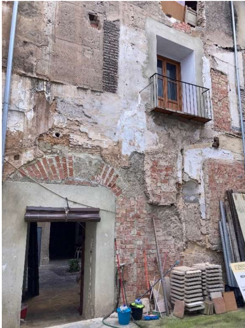
Mur de tancament posterior de la casa, després de reforçat. Foto MGB 2025
