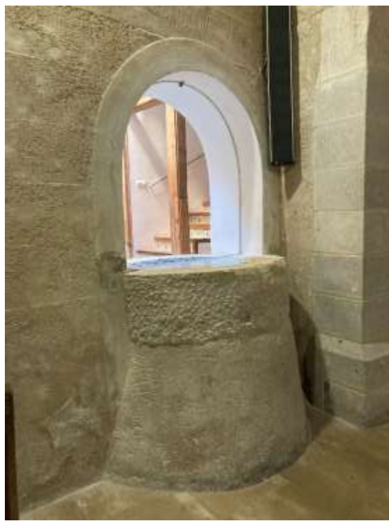
Brocal del pou obert en el mur existent entre el pati, a l'esquerra i la sala gòtica, a dreta. Fotos MGB. 2025
