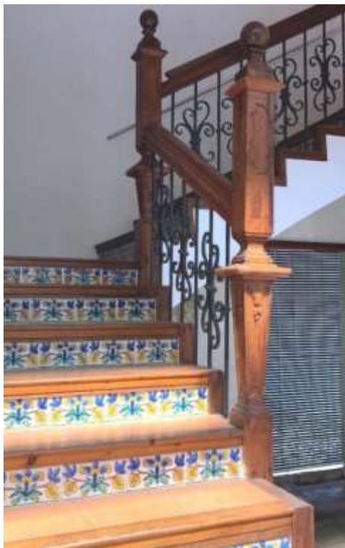
Balustre en estípit amb el fistó.
