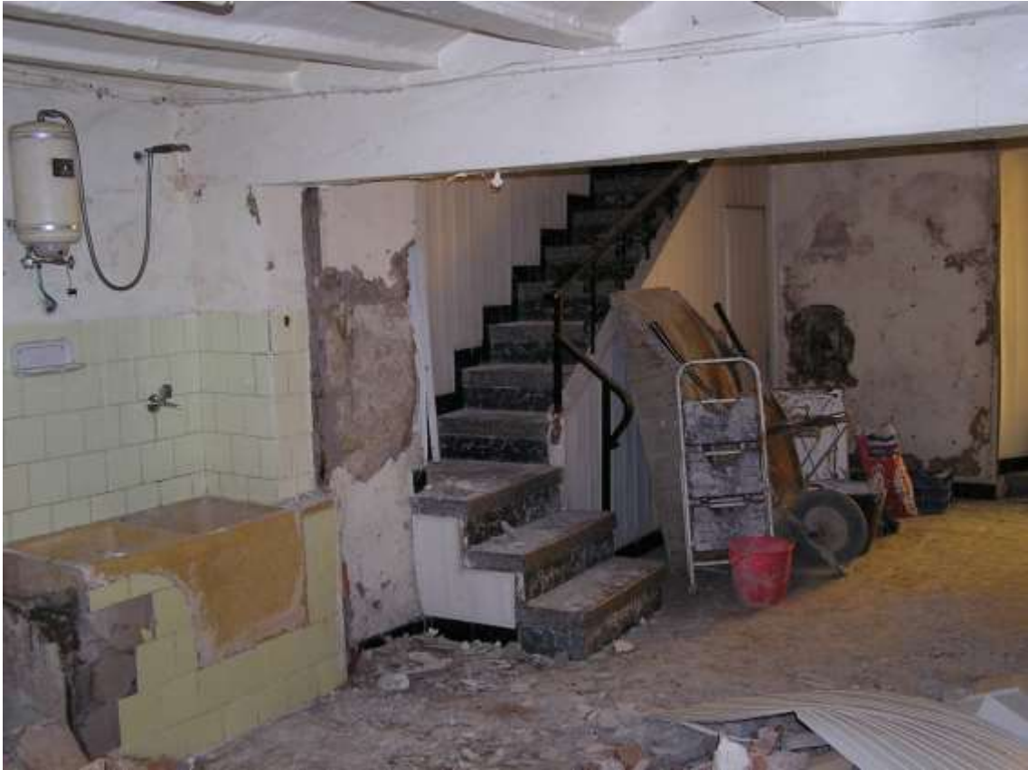
Planta baixa de la sala gòtica. Llavador, escaleta per pujar a la planta superior i, a la dreta de la imatge, la llum de la porta del carrer. Fotos V.TORREGROSA, 1995.
