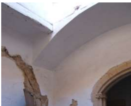
Extrem de ponent de la volta a la catalana Sustentadora del nou replà.
