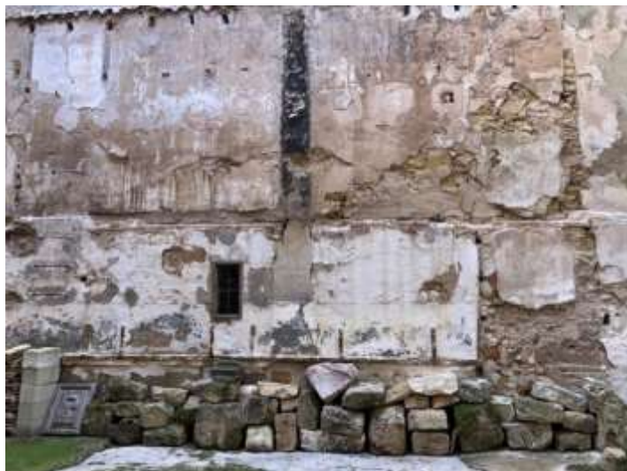
Mur del corral, mitjaner amb la casa dels Sanç de Sorió (Hostal del Peix). A la part inferior a la llarga, les restes dels pessebres, i més amunt la regata on s'encastaven les pallisses. A l'esquerra, els barrons de l'escala per a accedir-ne. Foto MGB 2025.
