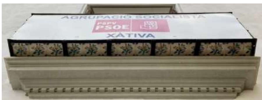
Taulells de ramell i cantoneres d'enllaç, en el sotabalcó de la façana. Foto MGB, 2025
