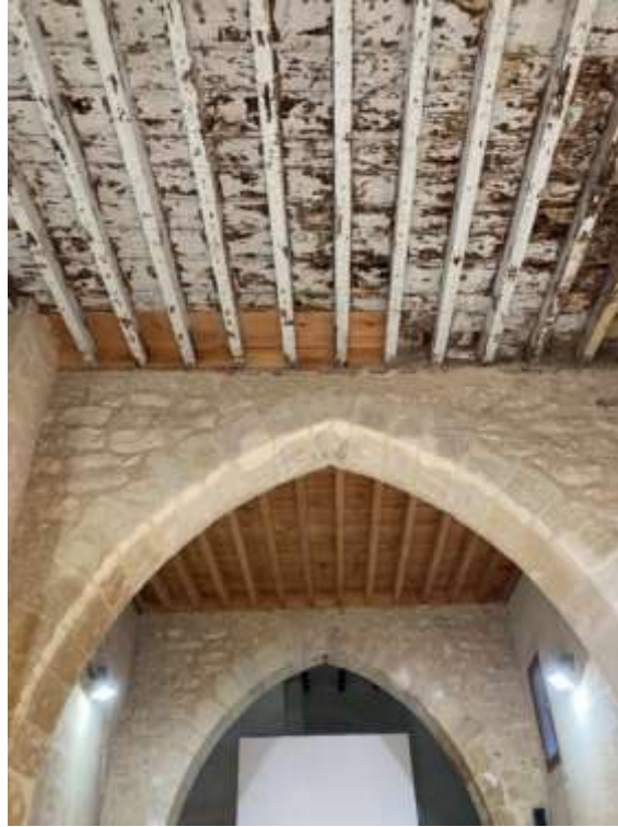
Sala d'arcs transversals i coberta de fusta de bigues perpendiculars a la façana. Una crugia original i l'altra refeta. Foto MGB, 2025
