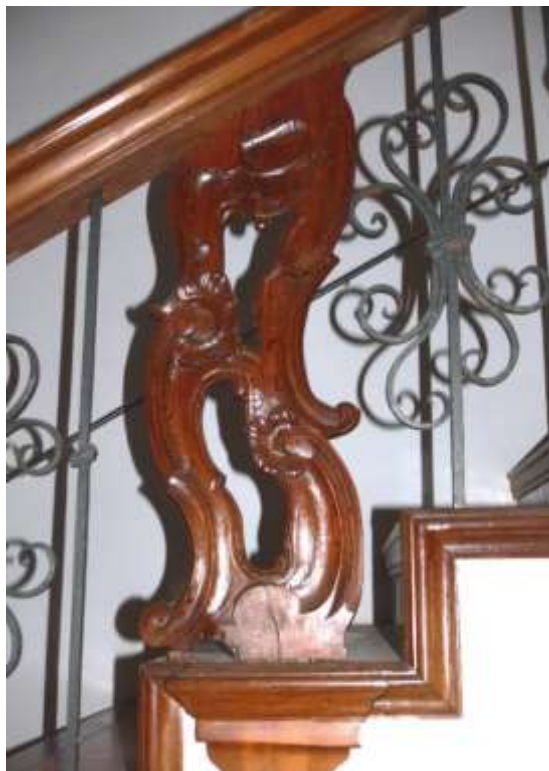
Plafó de talla de la barana, i ferratges de llaços. Fotos MGB, 2020 i 2018.
