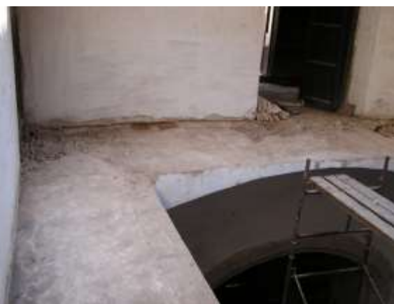
Nou replà sobre la volta a la catalana Fotos V. TORREGROSA 2005
