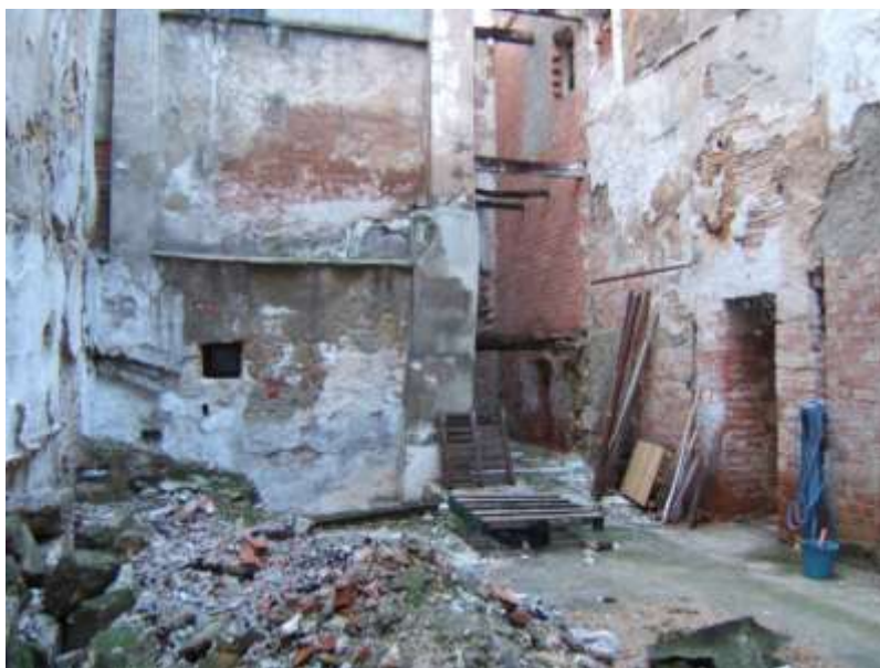
Vista oest del corral i racó on estava el galliner. Foto JV. TORREGROSA. 2005
