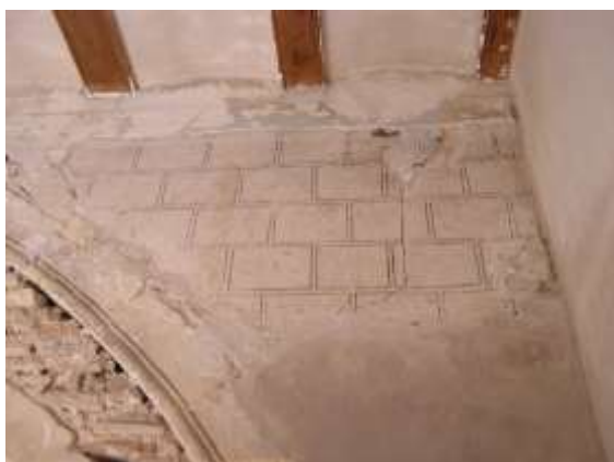
Enlлит original pintant a imitació de carreus. Esquerra, pany de ponent de l'entrada. Dreta, carcanyol de llevant de la cara interior de l'arc a la catalana, aparegut durant les obres. Fotos V. TORREGROSA 2005
