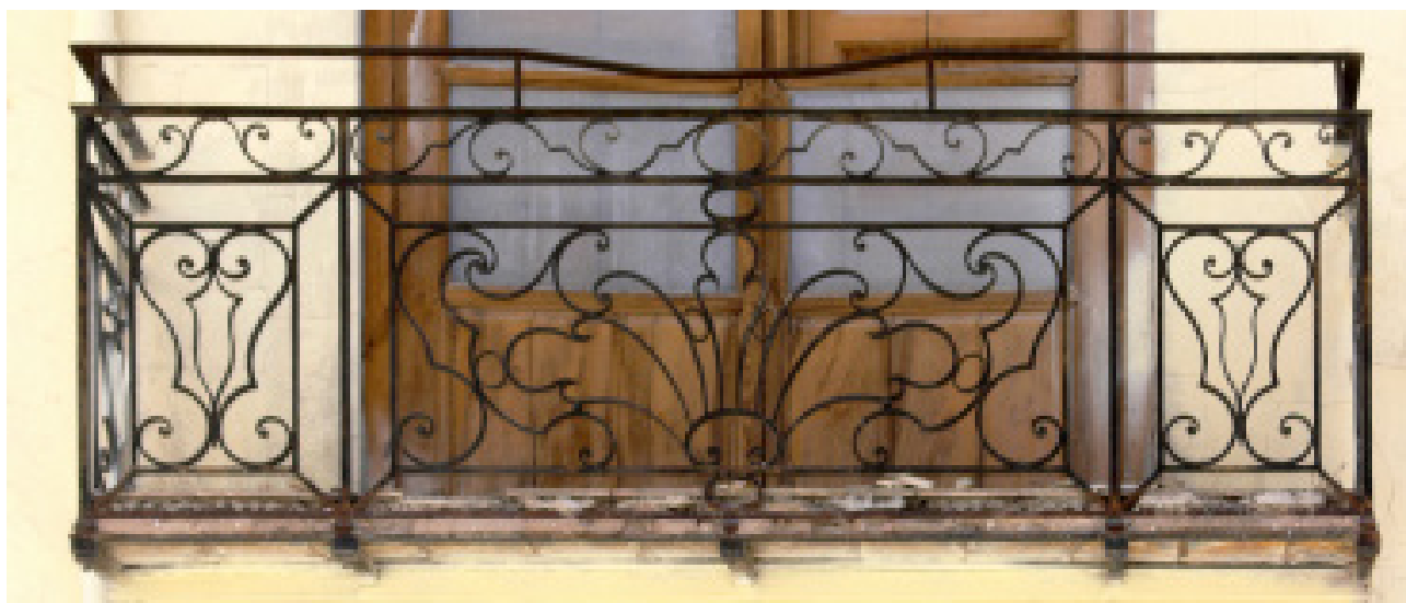
Ampit dels balcons de la primera planta. Forja de primers del XIX. Foto MGB. 2007
