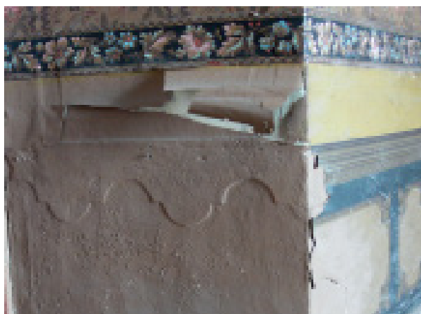
Esquerra, cinta i fistó ondulat esgrafiats en gris i blanc, corresponent al faldó del sòcol d'un dels salons, el qual va aparèixer intacte sota l'empaperat huitcentista. Dreta, idèntic fistó a la casa núm. 26 del carrer de la Caldereria. Fotos MGB, 2007 i 2011.
