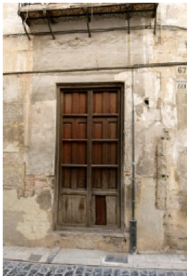
Portada de llinda recta de la casa del XVIII recaient a la Corretgeria. Va ser tapiada a finals del segle XIX i convertida en balcó de la planta baixa. En la dècada de 1960, va ser retirada la reixa de ferro colat.
