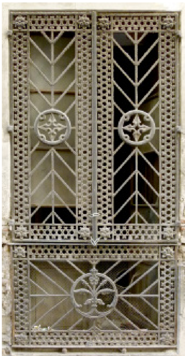
Reixa de ferro colat del balconet de la planta baixa, eliminada en la reforma. Foto MGB. 2011
