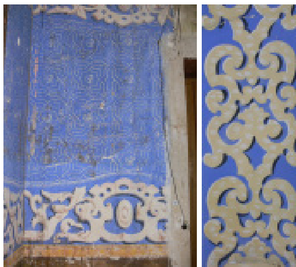
Ornamentació a trepa d'època romàntica, en murs i en revoltons conservats en part. Fotos MGB. 2008
