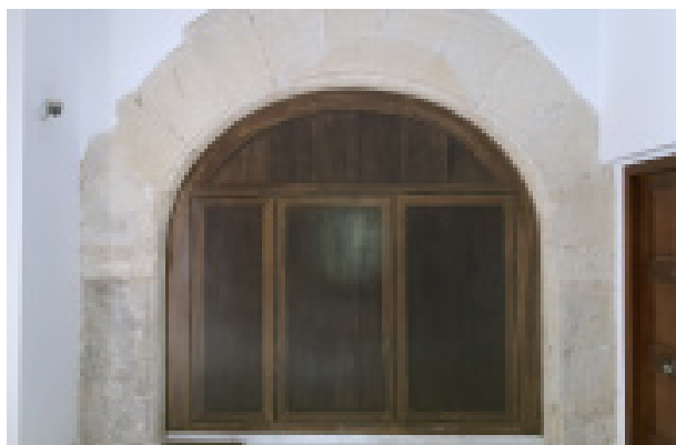
Arc medieval de mig punt rebaixat amb dovelles i bocell, de la primera crugia de la casa, entrant des de la Corretgeria.
