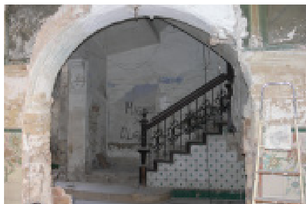
Arc de rajola que sustenta la segona crugia i dona pas a l'escala. Fotos MGB, 2022 i 2008.
