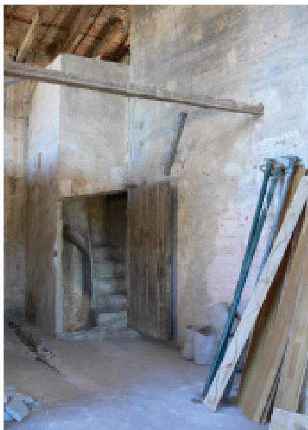
A l'esquerra, es veu la fàbrica on es va desprendre la crosta del morter. A la dreta, accés a l'andana. Fotos MGB, 2016.
