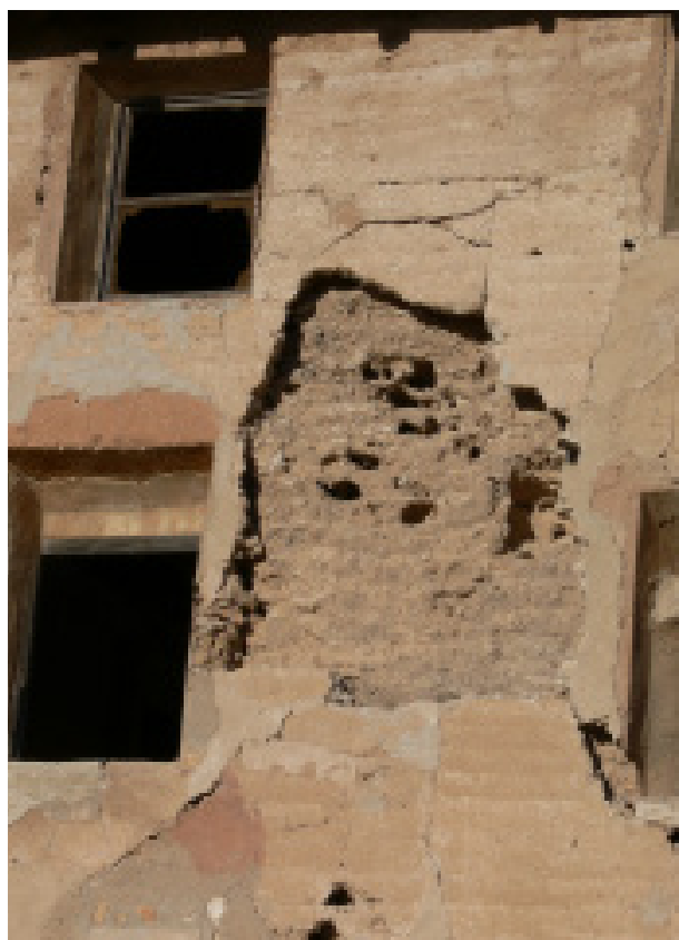
A l'esquerra, es veu la fàbrica on es va desprendre la crosta del morter. A la dreta, accés a l'andana. Fotos MGB, 2016.
