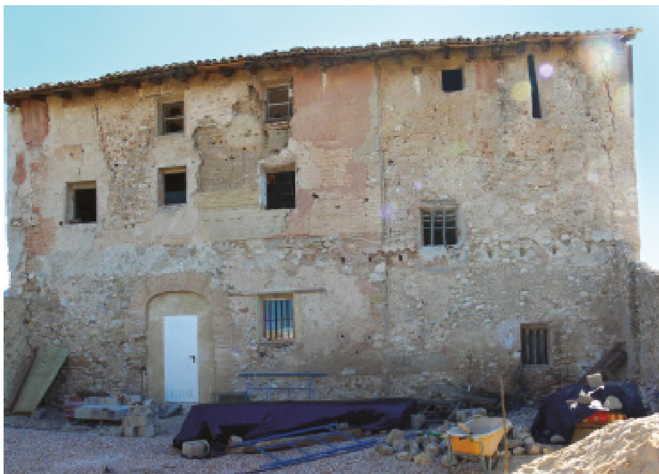
Façana posterior, on es distingeix la línia que separa la construcció original de l'afegida al segle XVI. Foto MGB, 2016
