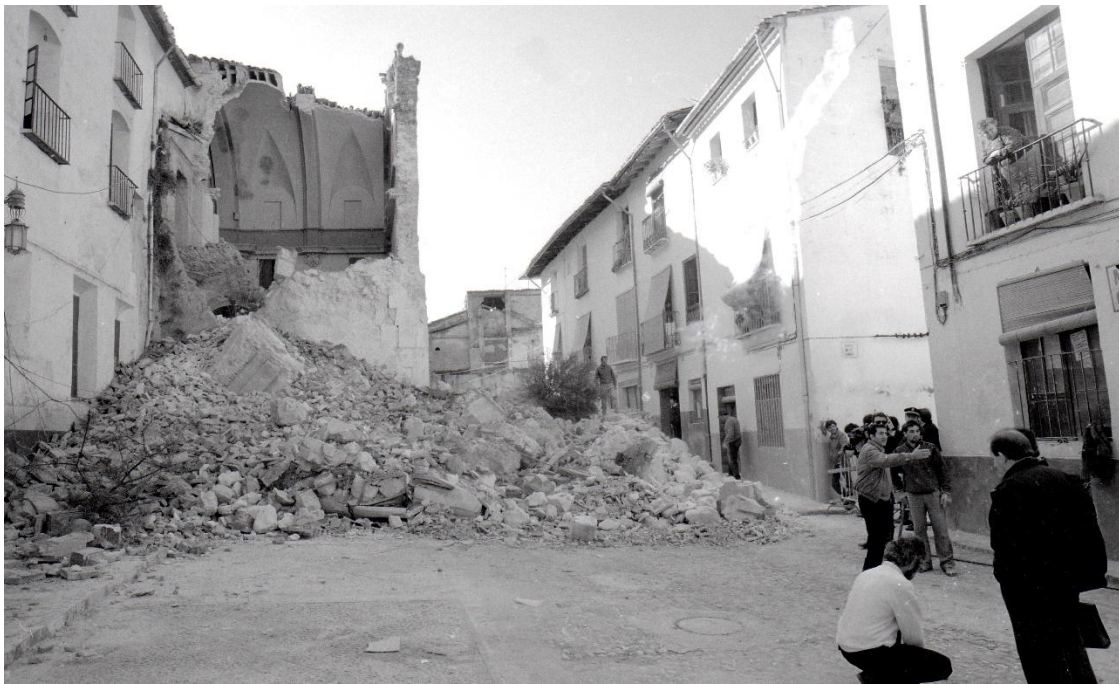
Esfondrament del campanar, el cor, dos capelles i part de la façana de l'església de Sant Agustí. Foto Perales Iborra 1991.
