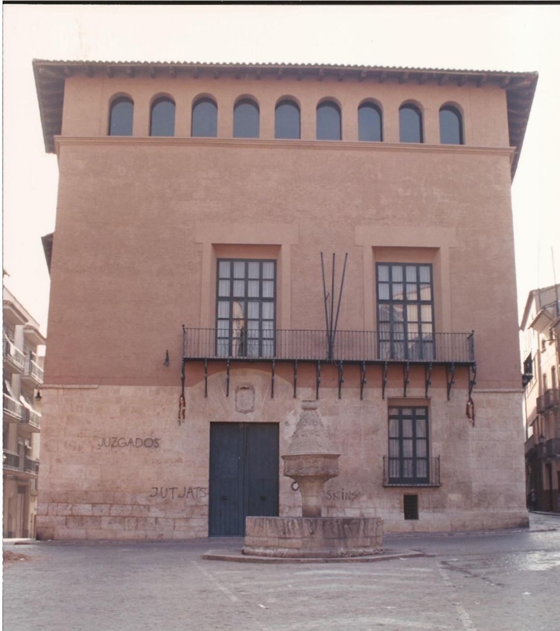
Palau d'Alarcó. Construït en el segle XVII pel governador de Xàtiva Cristòfol Cabanilles, amb la tècnica de la tàpia valenciana, oculta per l'enfoscament de l'errònia intervenció restauradora. Declarat monument en 1981. Foto 1990 de José Maria Gómez.
