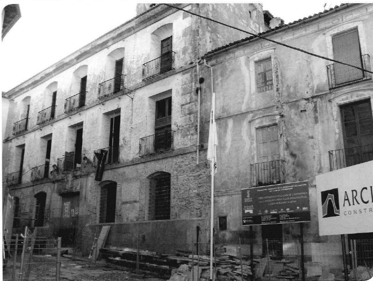
Façana de la Casa de l'Ensenyança. Inici de la rehabilitació de l'edifici per a ampliar el museu, segons projecte de l'arquitecte Josep Manuel Dapena. FOTO M. GONZÁLEZ, 2006. ARXIU FOTOGRÀFIC MUSEU DE L'ALMODÍ
