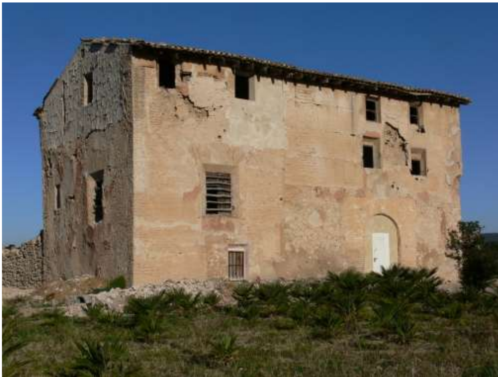
L'alqueria de Pròxita en una fotografia de l'any 2016. La part esquerra, ben diferenciada, és el cos d'edificació afegit al segle XVI. Foto MGB.
