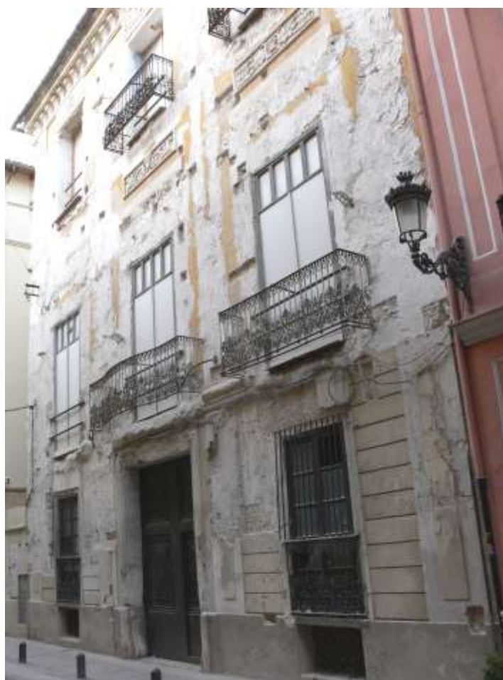
Fachada de la Casa Sanç d'Alboi. Estado actual. Foto MGB 2010
