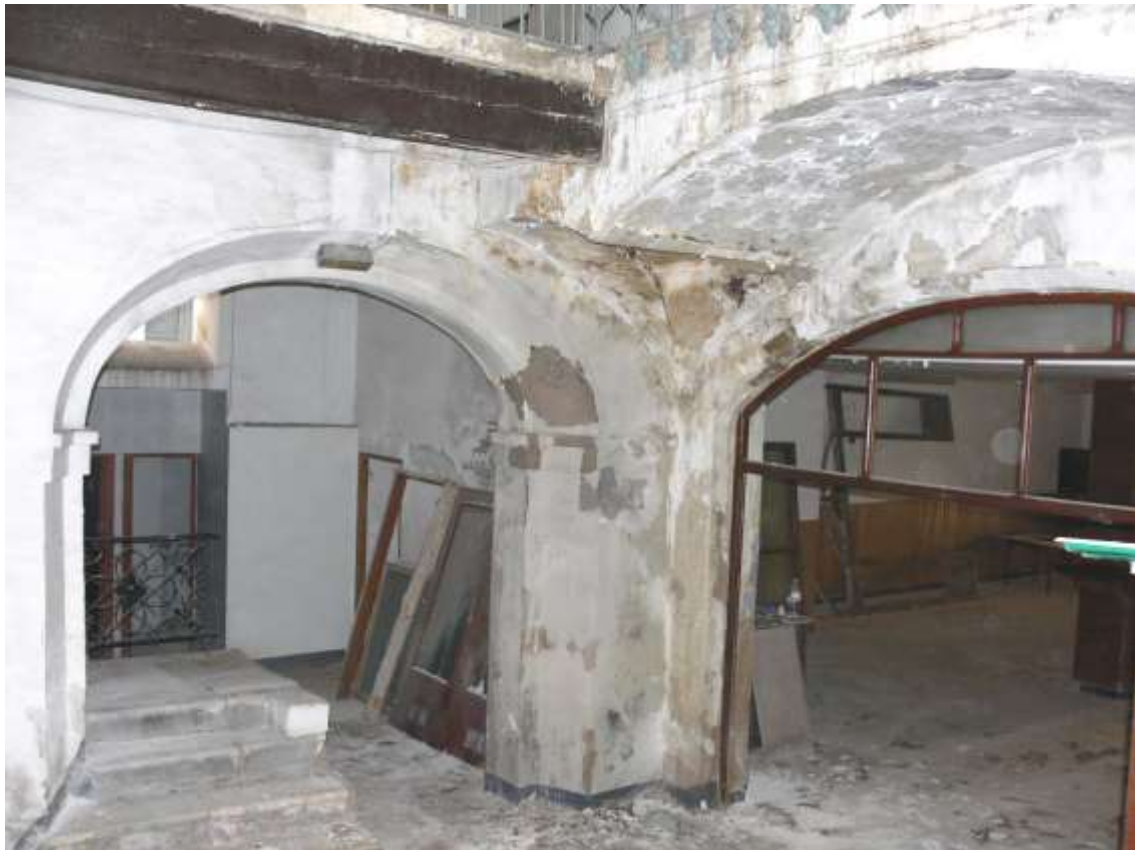
Ángulo de entrega de la escalera en el rellano de acceso a la sala. Foto MGB, 2010
