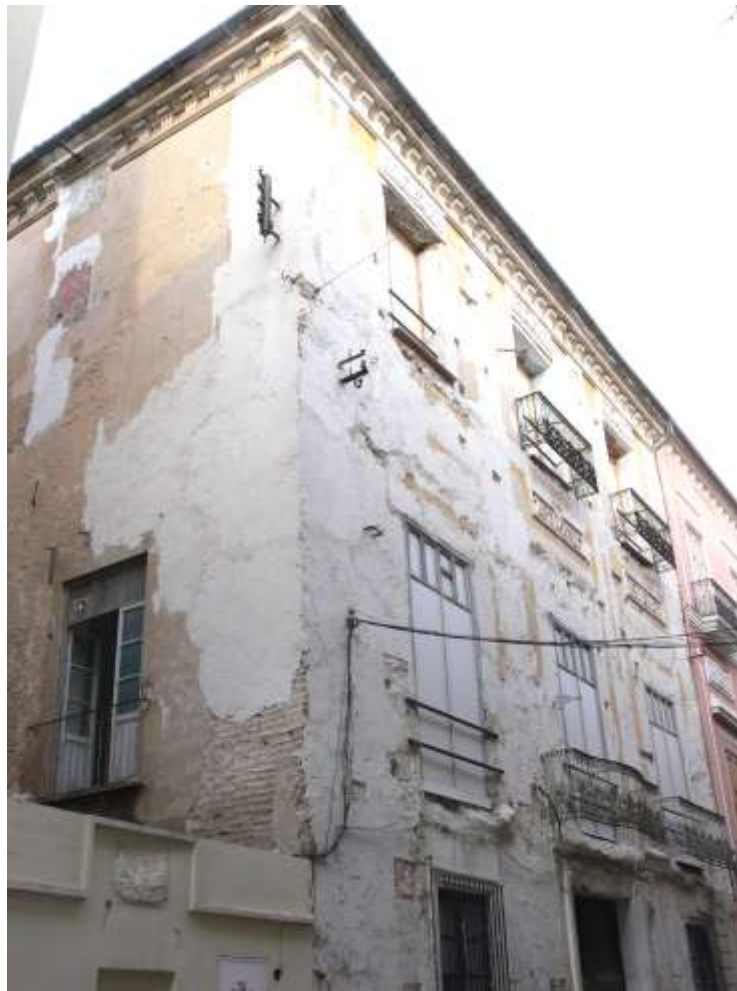
Fachada lateral recayente al callejón de antiguo acceso a la muralla y a los baños árabes. Foto MGB. 2010
