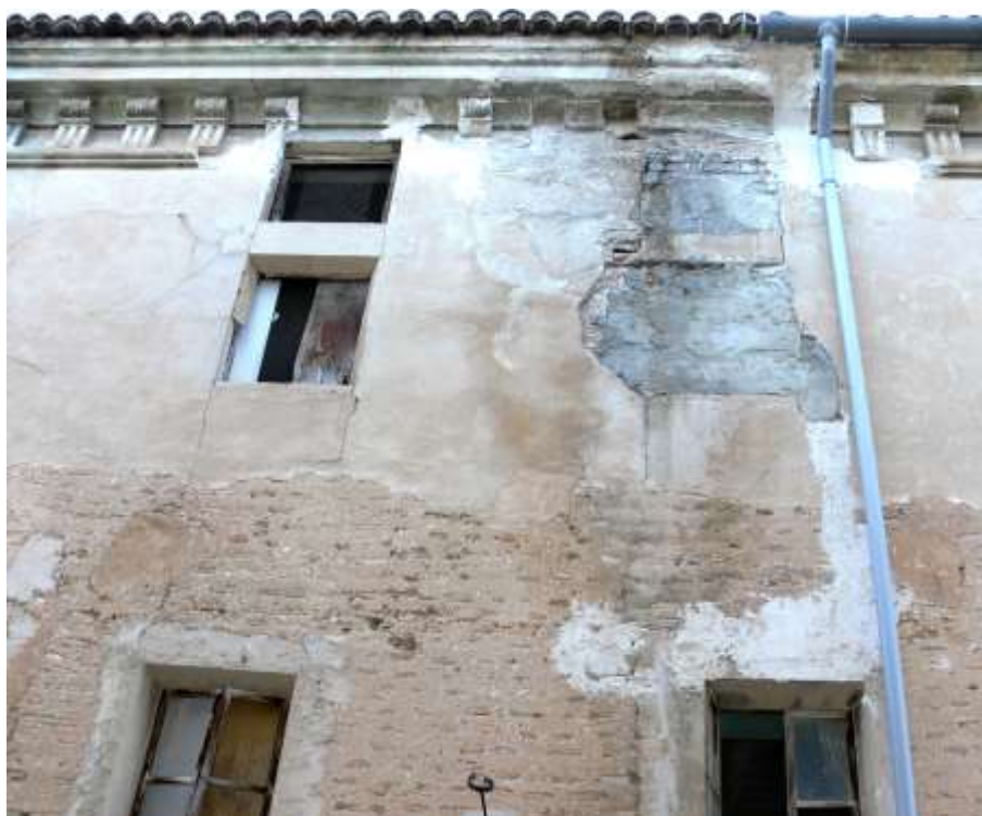
Cambio de fábrica en el recrecido de una planta. Foto MGB, 2010
