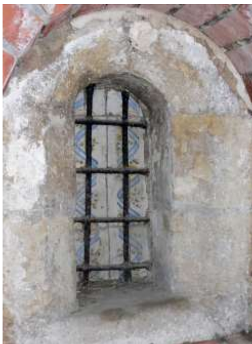
Ventana con reja, en la zona inferior de una torre de la muralla anterior a la Guerra de los dos Pedros, situada en el ángulo nordeste del otro lado del callejón. Foto MGB, 2010
