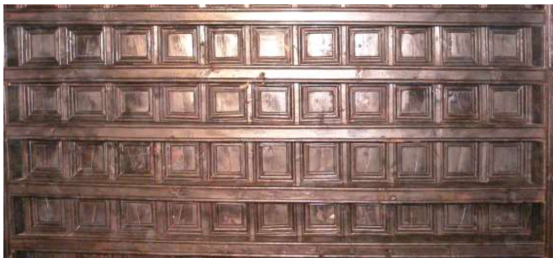
Casetones con molduras sobrepuestas al tablero. Foto MGB, 2010
