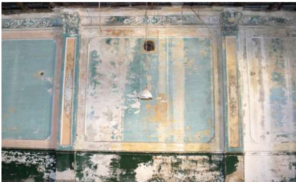
Decoración del muro de poniente del Salón de Baile del Casino Mercantil. Foto MGB, 2010
