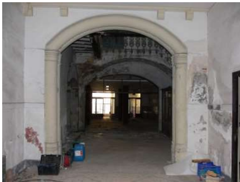
Arco de columnas pareadas, en la primera crujía. Foto mgb. 2010
