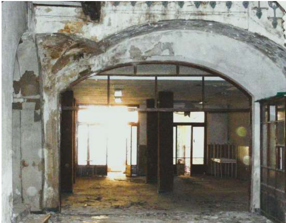
Bóveda de la escalera en su estado actual. Foto MGB. 2010
