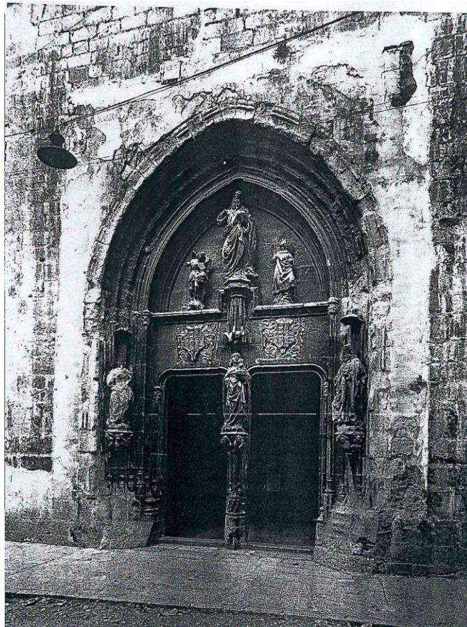
Fig. 2.- Fotografía en la que se aprecian con claridad las rozas enlucidas de yeso a uno y otro lado de las jambas, así como la que une las dos por la parte superior.
