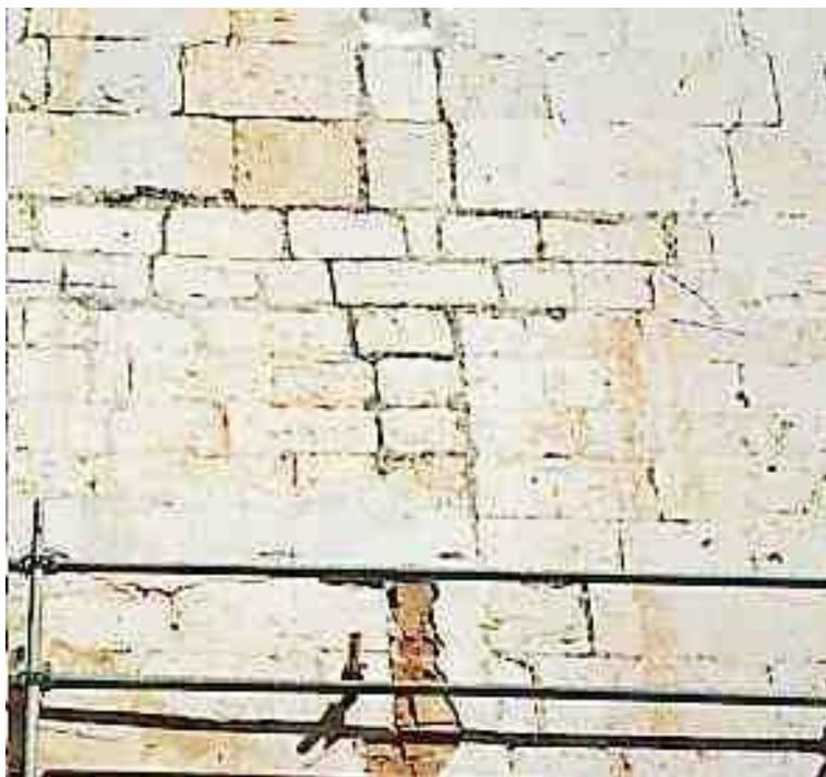
Fig. 3.- Detalle del lado superior derecho de la portada. Se aprecia la huella de un posible pináculo, cuyo hueco habría sido macizado, abajo, con ladrillo, y arriba, con piedra. Foto del autor
