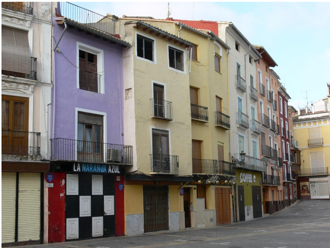
Costat que mira al nord, sense porticat. Foto MGB. 2014
