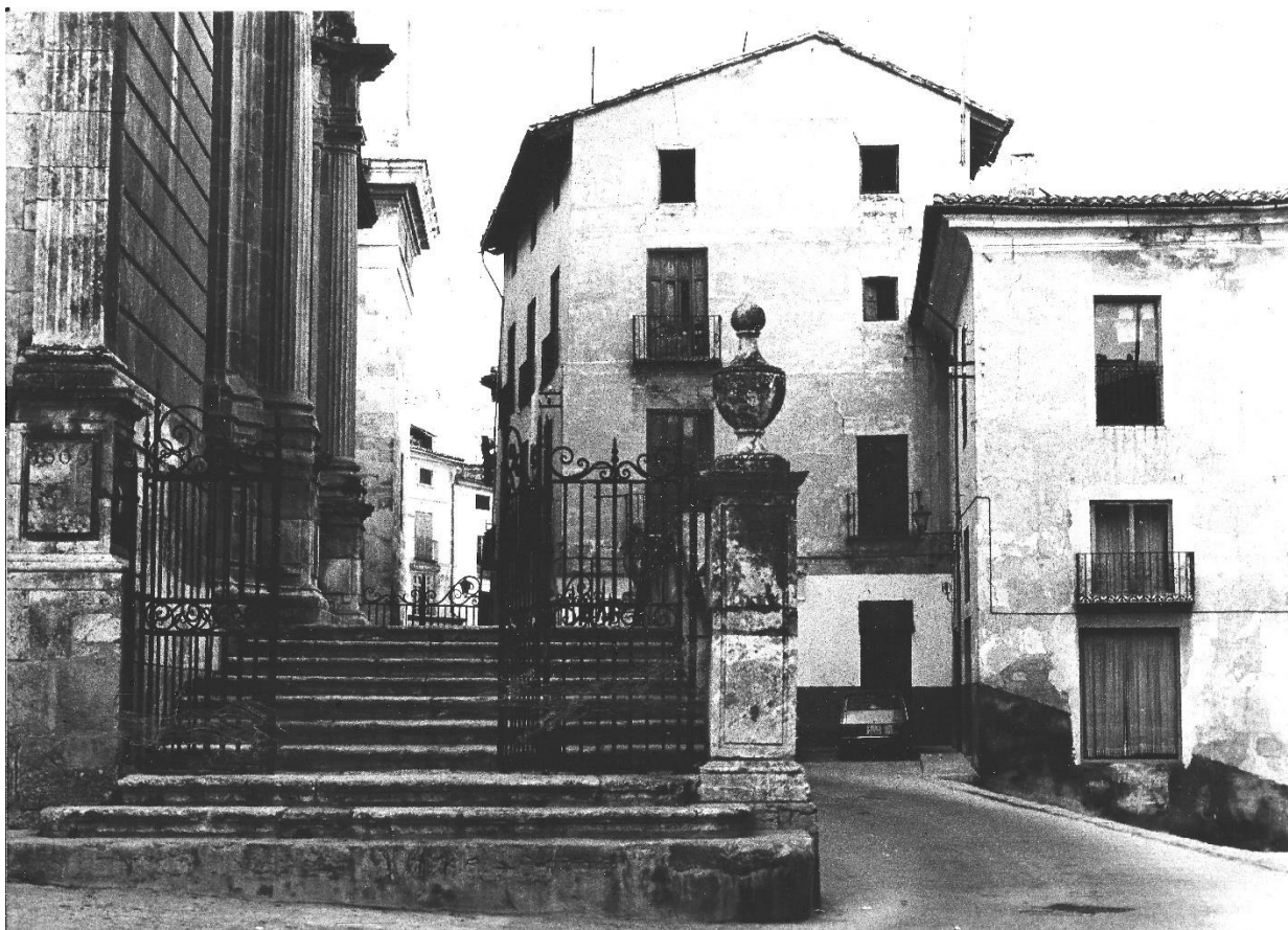
A la dreta, inici del carrer Sanchis, on estaven les cases de Josep Saurina i mossén Llorens Bru, enderrocades per a fer l'escala
