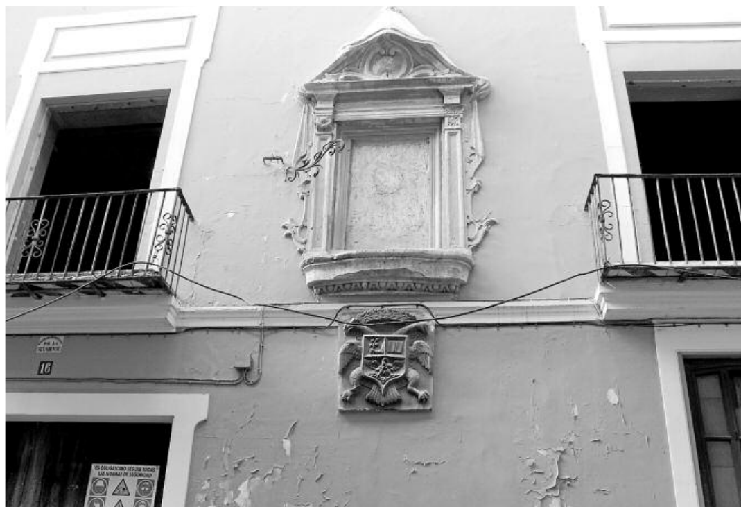
Façana del Palau del baró de Sacrolirio, al carrer de l'Àngel de Xàtiva.
