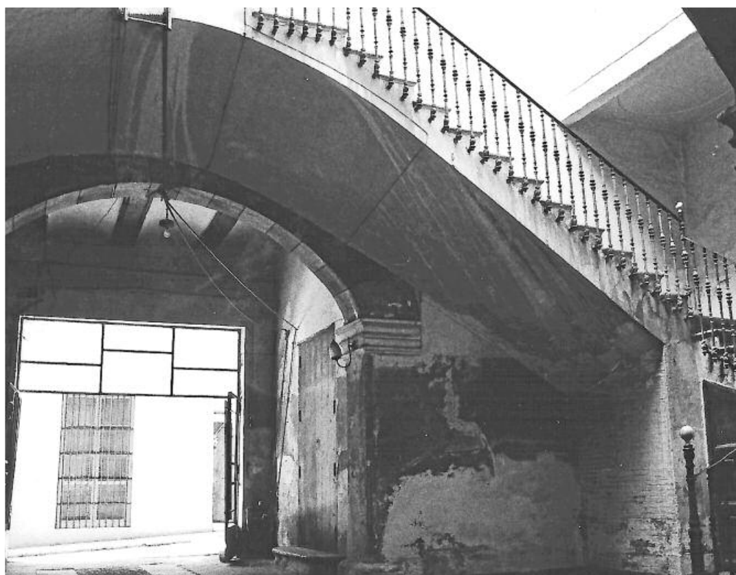
Dues imatges —des de la porta cap a dins i de dins cap a fora— del pati de la casa del Canonge Cebrià en els anys 70, abans de la restauració que li va donar l'aspecte que presenta actualment.
