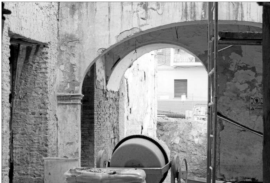
Fotografia de l'autor de l'interior de la Casa de l'Ensenyança de Xàtiva durant una de les etapes d'obres.
