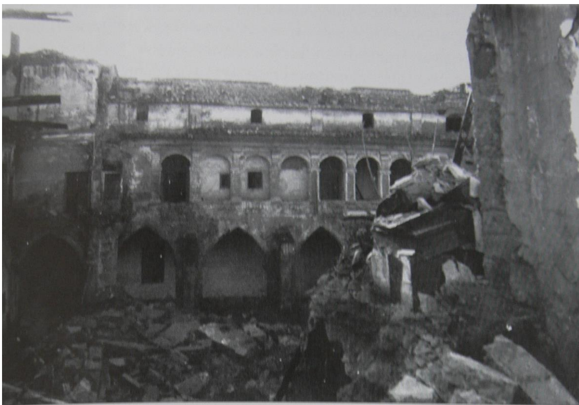
A l'esquerra, el claustre Llúria-Cardona, ja enderrocant. Foto presa des de les ruïnes de la Sala Capitular. 1972
