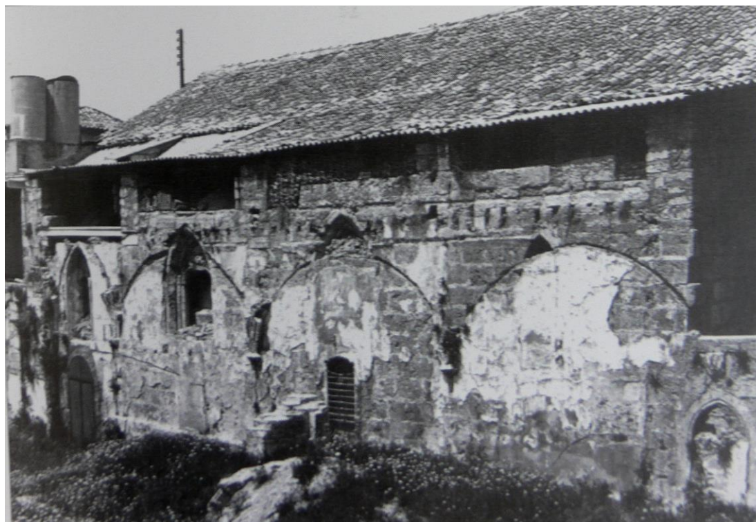
Façana sud de l'església. Observe's la marca del plement del claustre que va inutilitzar les finestres
