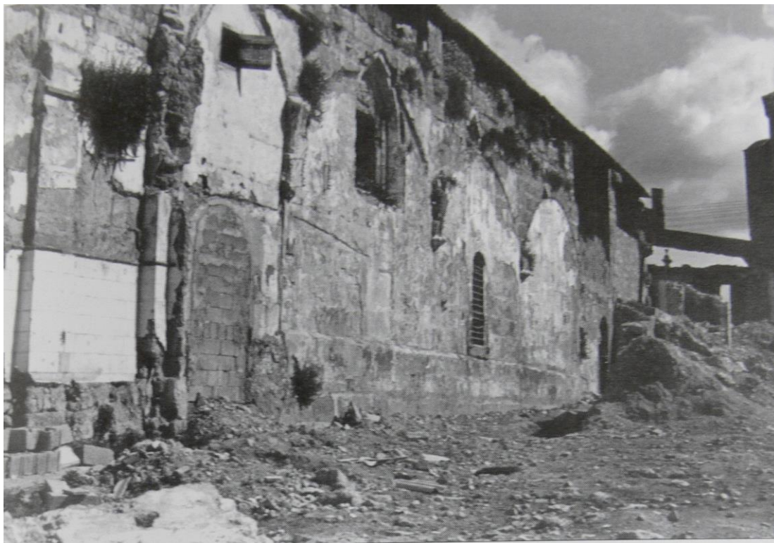
Façana sud de l'església. Fotografia de 1978 després de la darrera fase d'enderrocament del claustre
