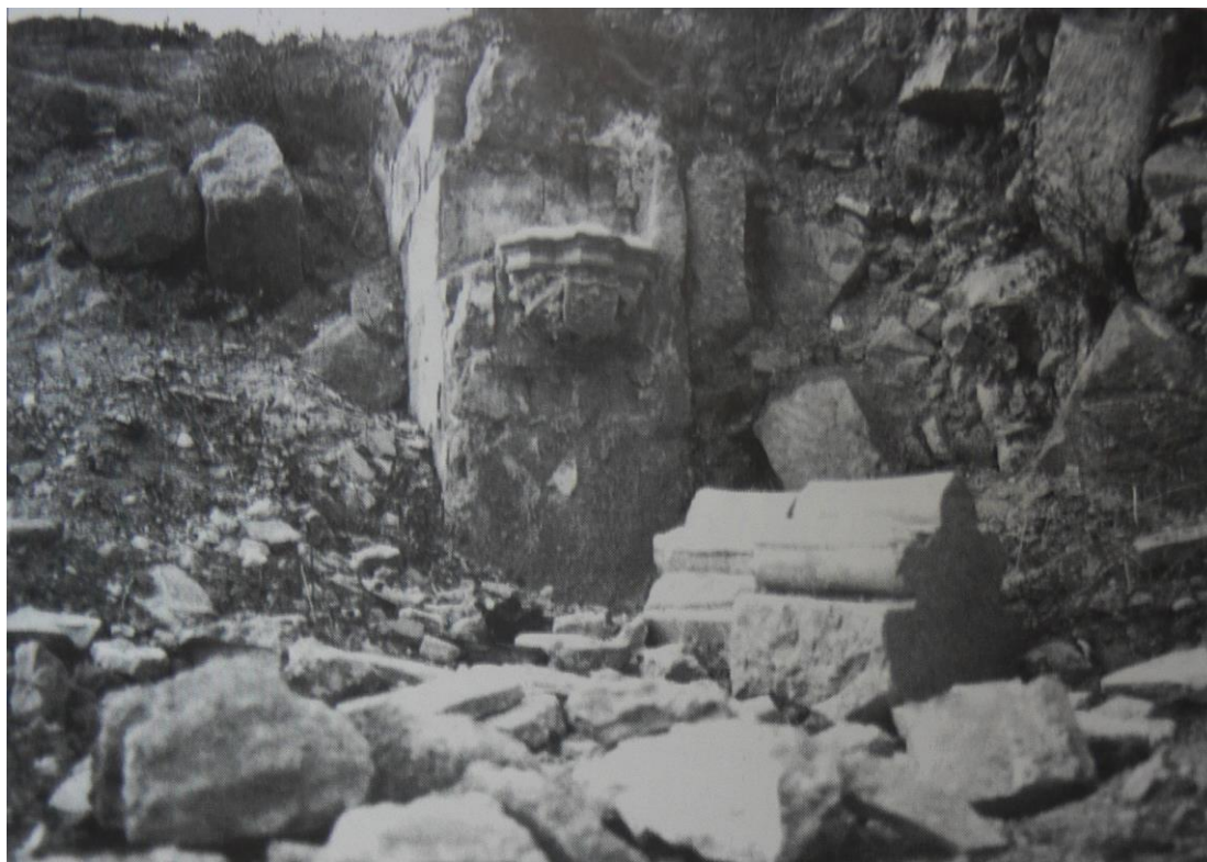
Contrafort del refectori i mènsula amb l'escut der Maria de Cardona. Campanya de desenrunament de 1985
