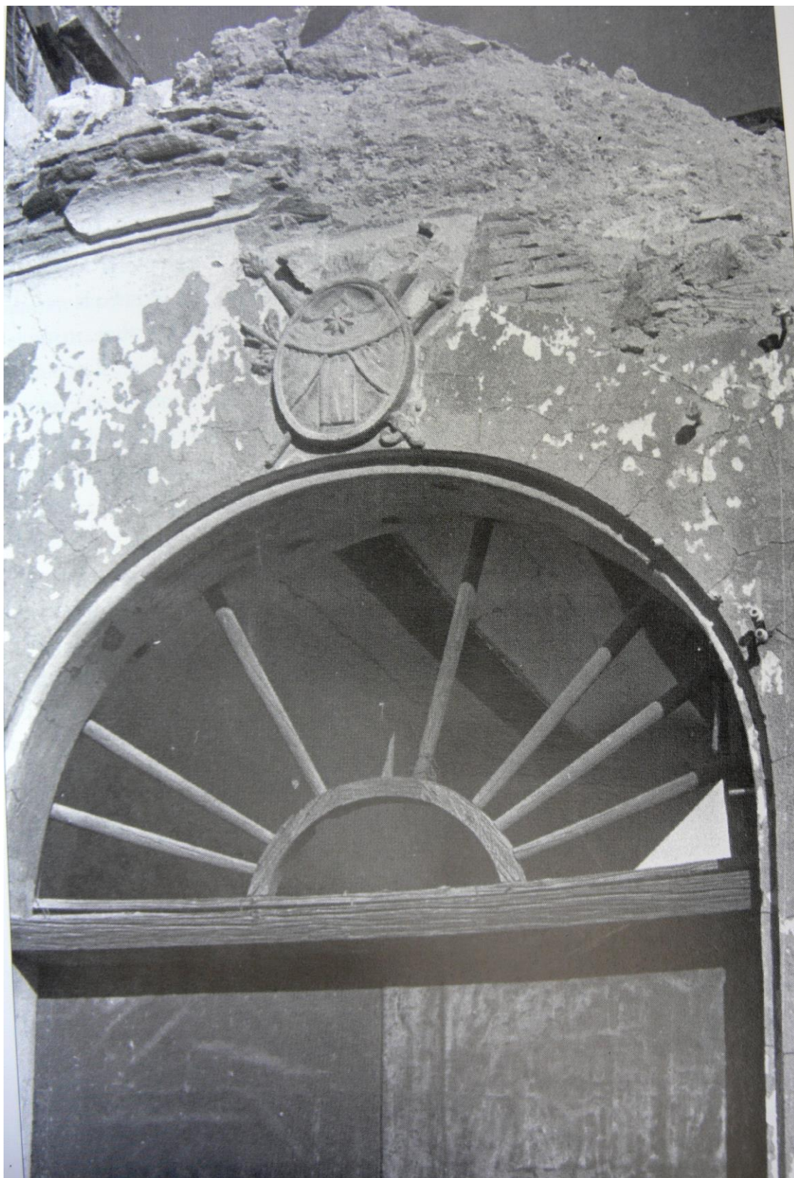
Enderrocament de la porteria. Fotografia posterior a 1973
