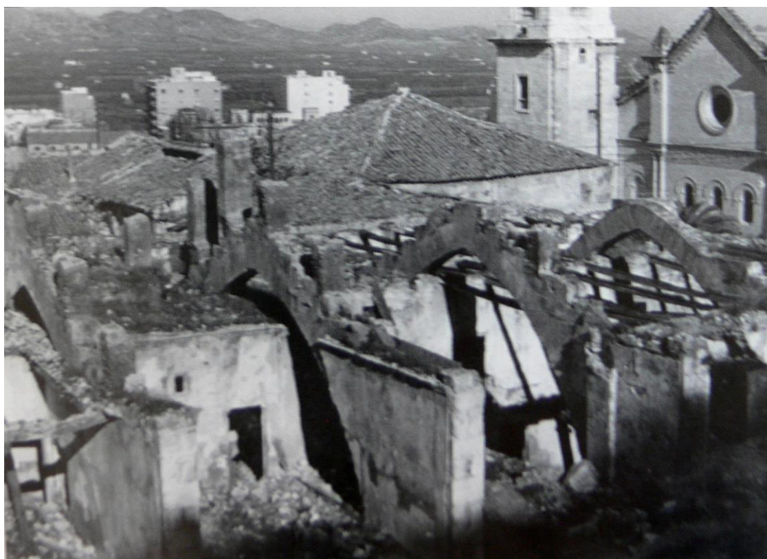
Arcs diafragmàtics del refectori apareguts durant la 1ª fase de l'enderrocament de 1966. Observe's el forjat afegit al segle XVIII, que divideix l'altura en dues plantes, i els pilars per alçar la teulada. Foto de 1972
