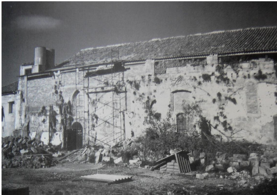
Façana sud de l'església. Reparació de les cobertes. 1990
